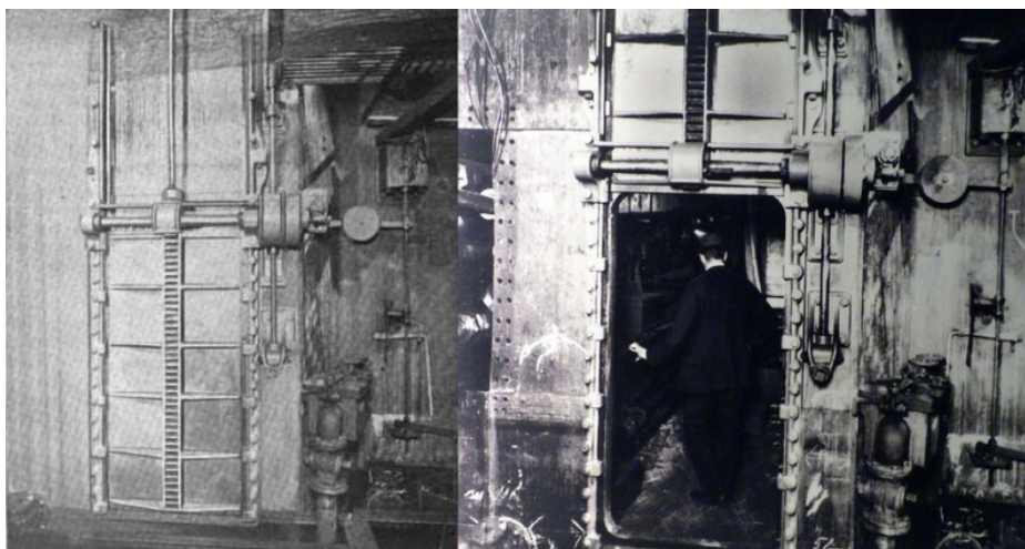
Figur 0159 Vanntett dør (RMS Olympic og RMS Titanic).
