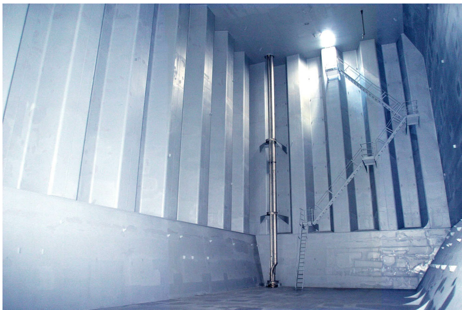
Figur 8.07 Lastetank på kjemikalieskip, tanken er av rustfritt stål 316 L.
