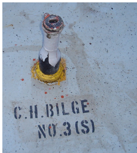
Figur 10.11 Peilerørplugg oppe å på dekk, C.H. Bilge NO. 3 (S) (Cargo hold lensebrønn nr. 3 styrbord)
